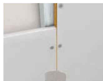
Rebouchage des surfaces après la réalisation du joint colle
