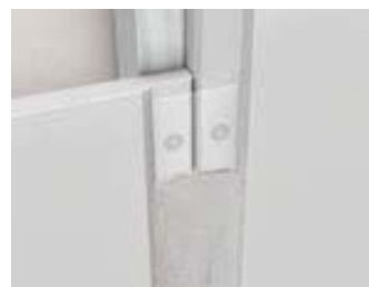
Jointoiment des plaques à bords amincis
